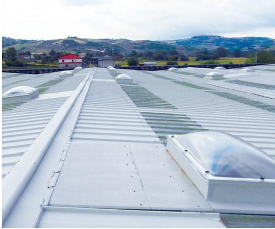
Basamenti, da comporre in opera, per accoppiamento a coperture a doppia pendenza in pannelli sandwich grecati rettilinei, posizionabili sia con lato corto che con lato lungo paralleli al colmo, realizzati con sezione a C in lamiera di acciaio con finiture cromatiche, altezza e pannello di coibentazione in poliuretano personalizzabili in funzione delle esigenze di progetto.
