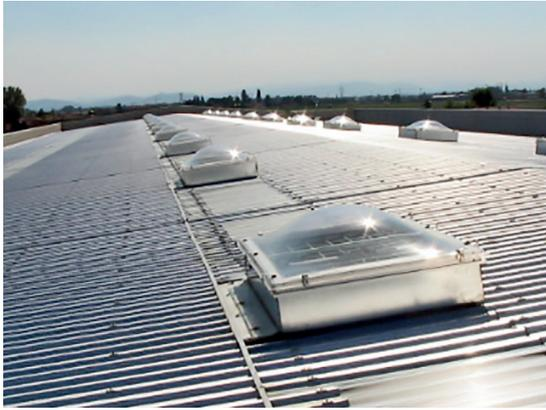
Basamenti, da comporre in opera, per accoppiamento a coperture in lamiere grecate rettilinee, realizzati con sezione a C in lamiera di acciaio con finiture cromatiche, altezza e pannello di coibentazione in poliuretano personalizzabili in funzione delle esigenze di progetto.
