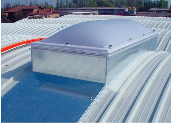
Basamenti, da comporre in opera, per accoppiamento a coperture con pannello sandwich curvo coibentato realizzati in lamiera di acciaio con finiture cromatiche, altezza e pannello di coibentazione in poliuretano personalizzabili in funzione delle esigenze di progetto e sagomati per essere, su due lati, sovrapposti alla copertura e su due lati appoggiati sulle travi.
